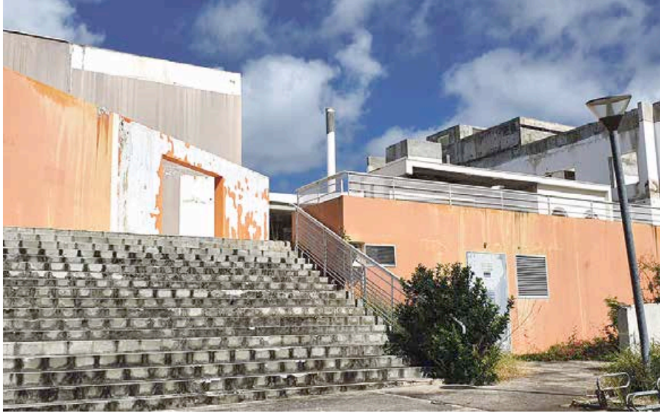
La première phase des travaux de la médiathèque sont achevés. Les bâtiments détruits ont été déconstruits et ceux restants entièrement nettoyés. La phase deux des travaux de reconstruction est prévue pour cette année, avec une enveloppe budgétaire de 2.5M€.
