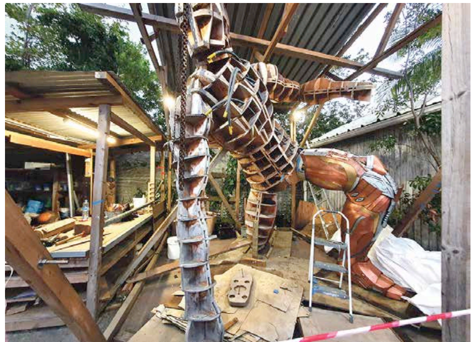
L'ossature en bois, colonne vertébrale de la sculpture, est achevée. ZincArt procède maintenant à la recouvrir de cuivre, de laiton et de zinc.
