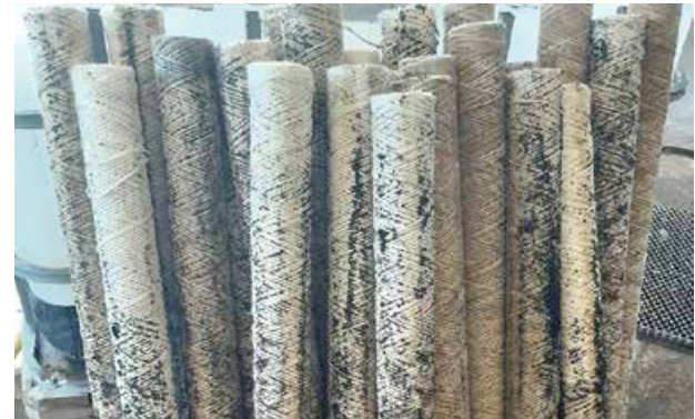
Etat des filtres après l'épisode de houle ... leur nettoyage nécessite trois à cinq heures d'intervention
