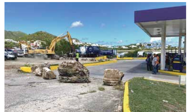
Depuis vendredi, des roches bloquent l'accès aux pompes de la station essence de la Baie Orientale. La boutique reste accessible à pieds.
