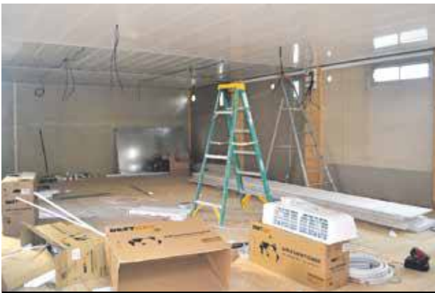
Vendredi dernier, les algécos étaient toujours en travaux. Suite à la pression engagée par le Collectif "parents, enseignants, enfant", les entreprises ont travaillé durant le week-end pour que ces salles supplémentaires soient opérationnelles lundi.
